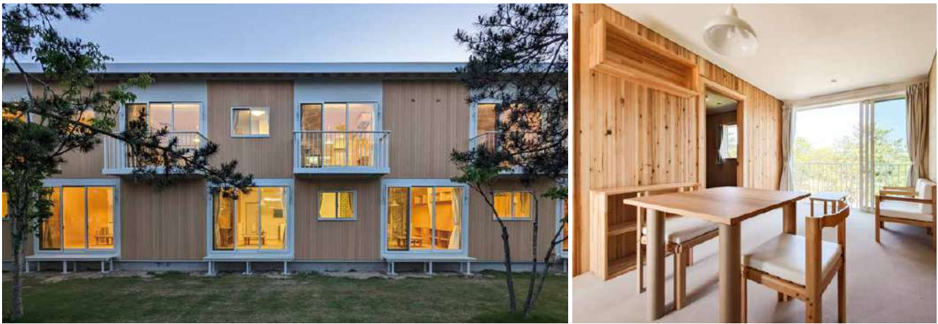
石川県珠洲市の木造仮設住宅。DLT をトンネル型に組んで構造体とし、千鳥状に重ね居住空間とした。DLT が意匠と構造を兼ねたデザイン。2024 年ウッドデザイン賞最優秀賞受賞。
