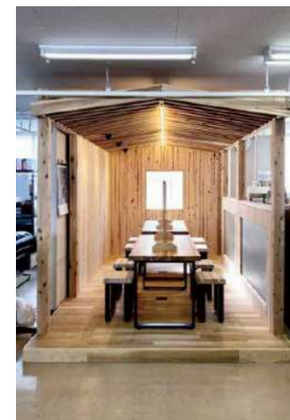
秋田スギを活用した打ち合わせスペース。壁面の DLT に秋田スギを使用。
