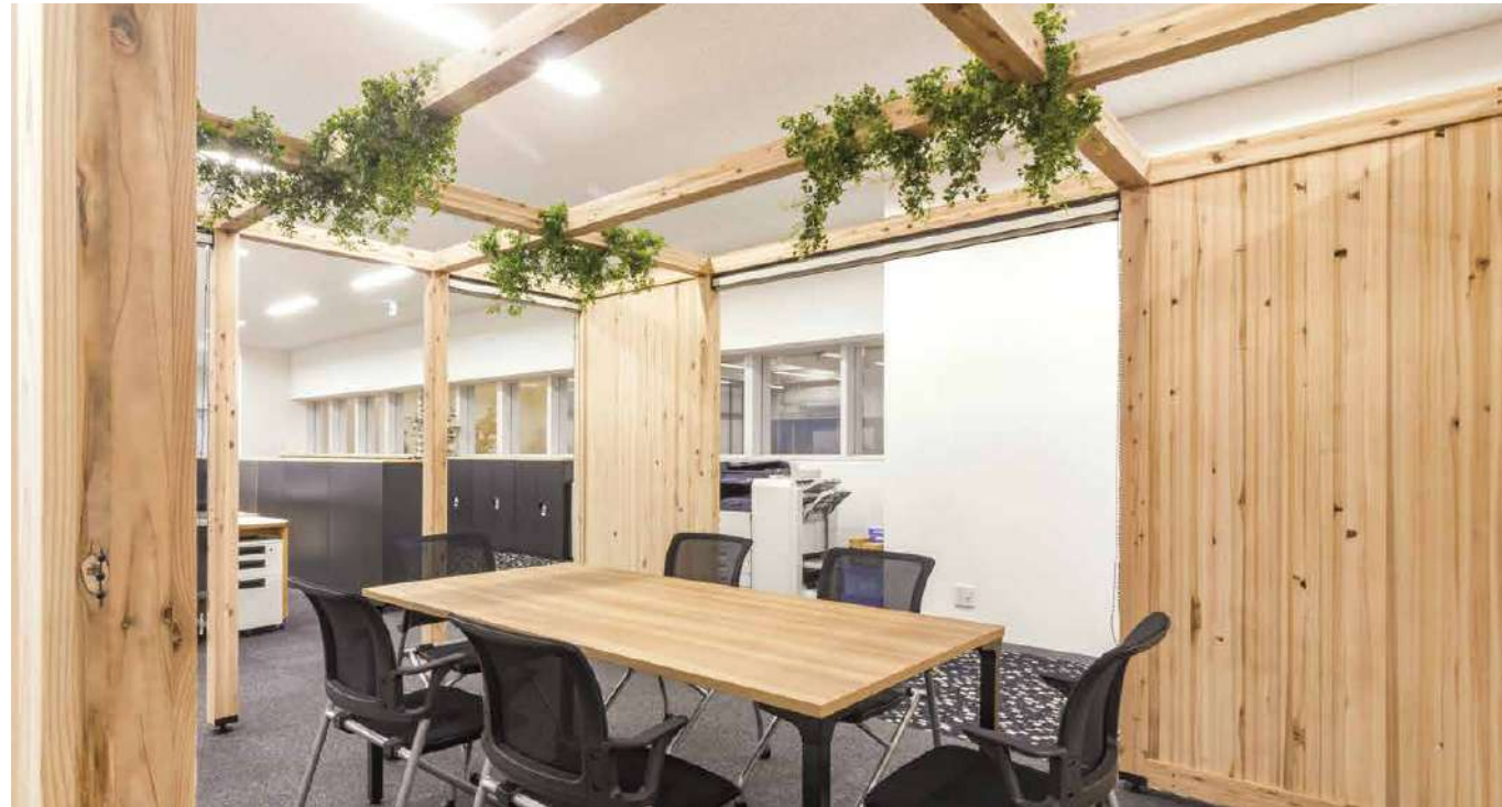
木の柱や梁を用いた「やぐら」による木質化。一部の壁には DLT を使用。
