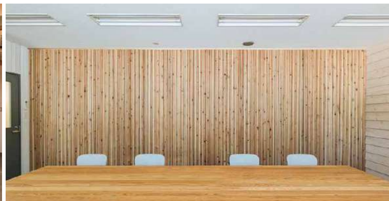
壁に吸音タイプの DLT を使用。会議中の音の反響を抑え、快適な音響空間を実現。
